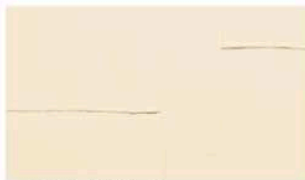
ヘラ ヒキズリ仕上げ 市販のヘラでヘラ跡を残して模様を付けます。
