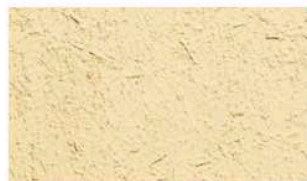
ウールローラー仕上げ (藁すさ+寒水石入) 下塗りを行い乾燥させた後、藁すさ(30g/m 2 )と寒水石(3厘・100g/m 2 )を混ぜた材料で仕上げます。
