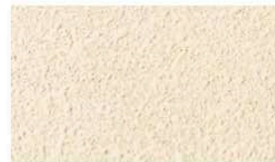
吹付け仕上げ リシンガンで下地が透けないように2度吹きします。
