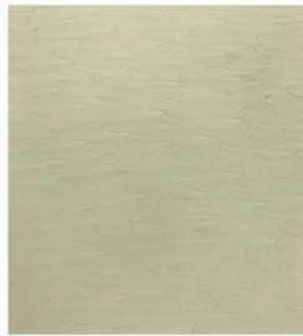
ヒキズリ横仕上げ コテ 先端を使用
