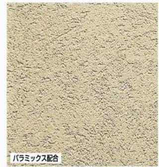
水石配合 木鏝押さえ仕上げ コテ + 木鏝
