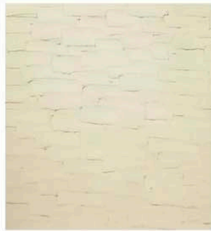
ヒキズリ横仕上げ コテ 後部を使用
