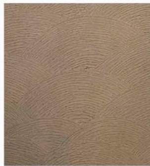
パイプローラー 扇仕上げ コテ + ローラー
