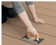
デッキ表面にキズがついた場合、市販のサンドペーパー(60番)で表面を長手方向の節目に合わせ、キズなどが生じた部分を周囲と全体的にほかす感じでこするときれいに補修できます。平らな広い面を修復する場合、サンドペーパーホルダー(サンドペーパーを取り付ける道具)を使うと楽に修復できます。
